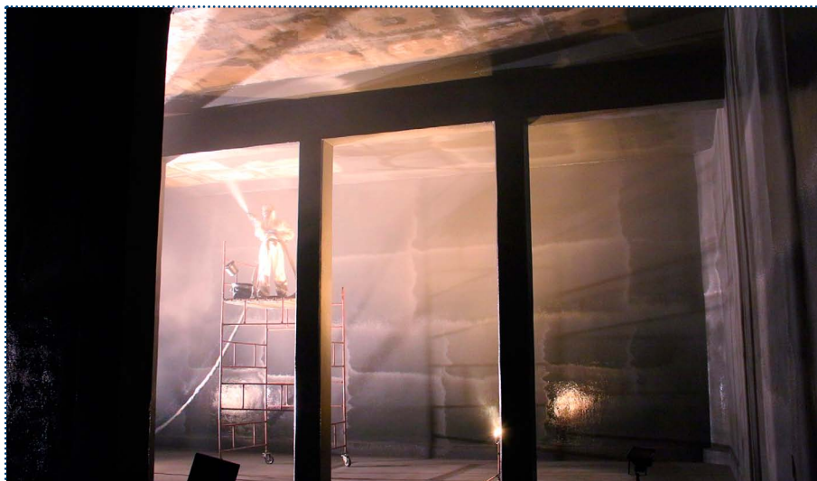
Fot. 4. Nakładanie warstwy polimocznika [1]
